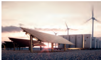
Energieerzeugung und -speicherung
